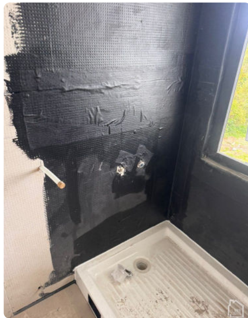
Impermeabilización de la ducha antes del porcelanato.
