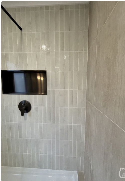
Baño terminado: porcelanato, nicho y grifería empotrada.
