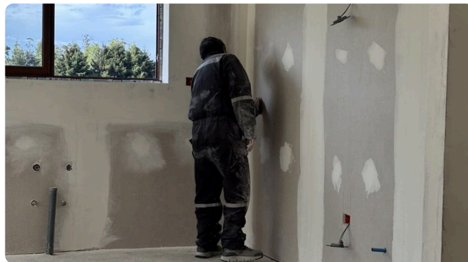
Preparación de superficies en obra.
