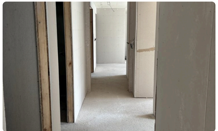
Pasillo en obra, listo para la preparación de superficies.
