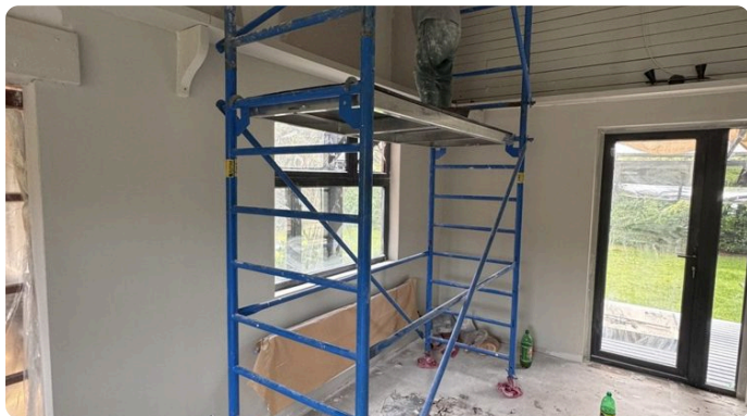
Cielos altos: obras que exigen andamios y coordinación.
