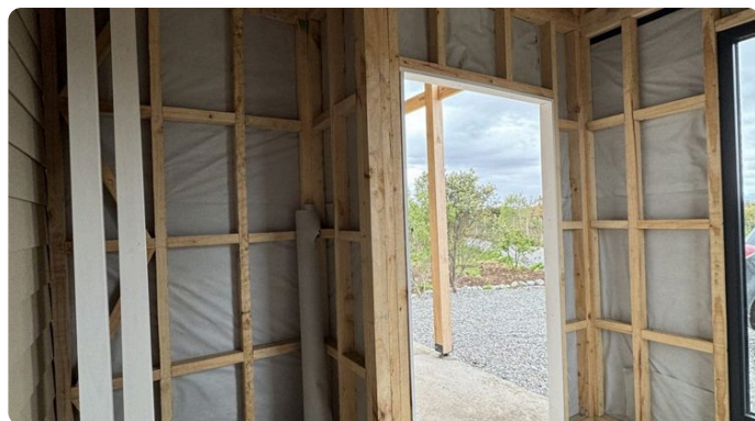
Tabiquería de madera: se revisa antes de cerrar.
