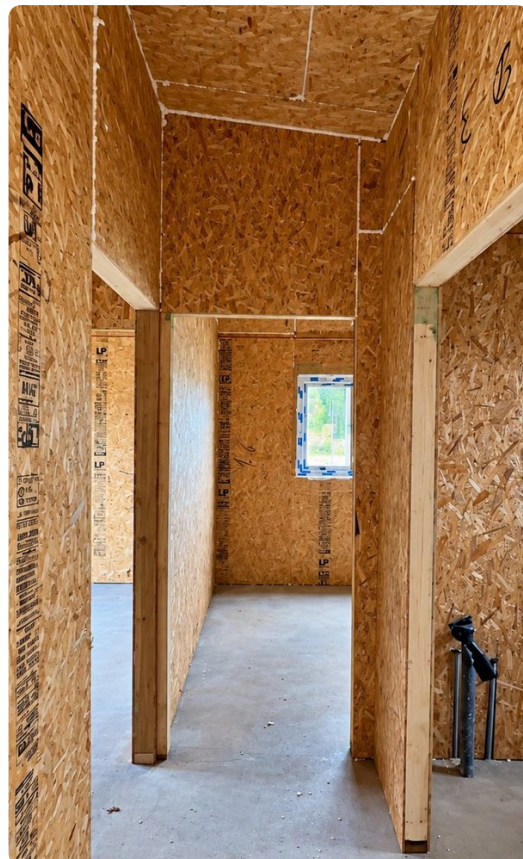
Casa SIP en obra gruesa: paneles, desagües y radier a la vista.
